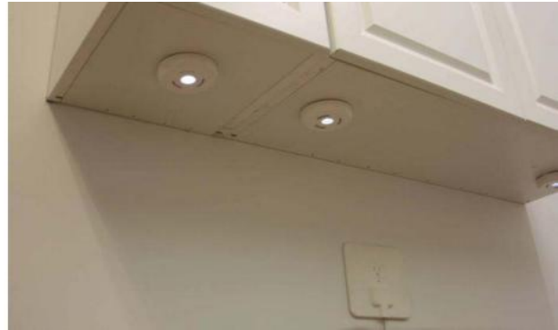
LED ნათურები, რომლებიც პირდაპირ იკვებებიან HR-WPT სისტემის მიერ
