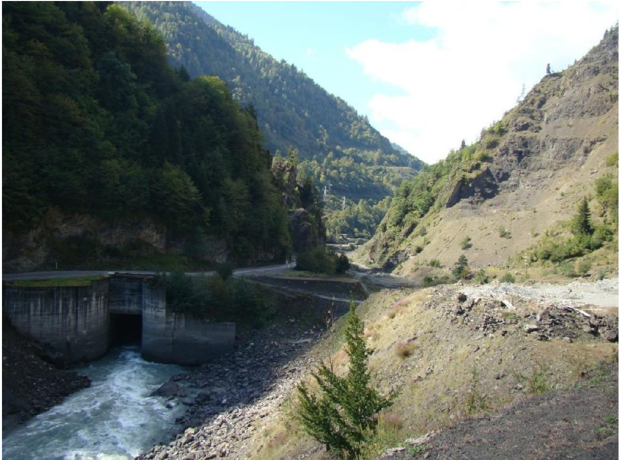
სურ 1. ასაშენებელი კაშხლის კვეთი და წყალგამყვან გვირაბში გამდინარე მდ. ენგური.
